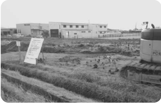
2月から舟木建設による造成工事が始まりました
