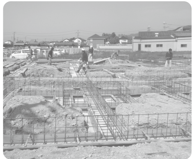
着々と建設が進んでいます！
