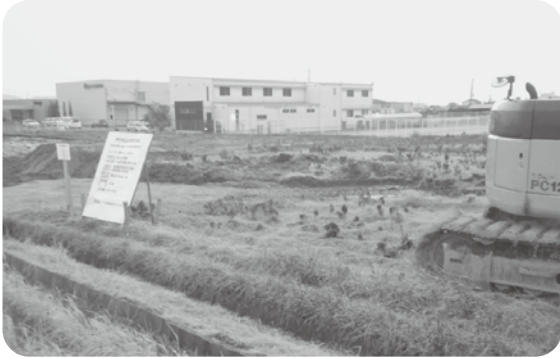
2月から船木建設による造成工事が始まりました
